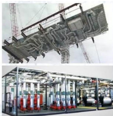
第三級: 組裝多種屋宇裝備結合成為 多工合成構件
