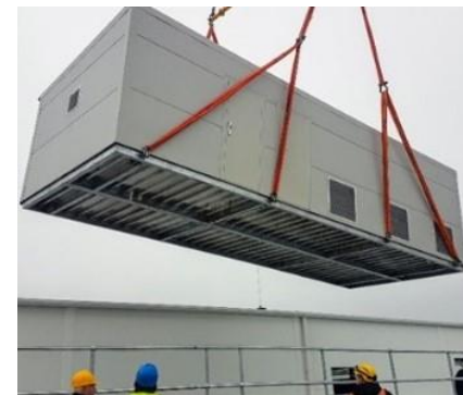
第四級: MiC+MiMEP 結合建築結構 及裝飾合成機房模組
