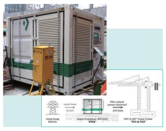
AMPD「淨能櫃」是首個專為建築工地設計的先進電池系統,輸電量高達400千伏安(kVA),足以取代傳統柴油發電機,成為工地主要供電來源。為免供電中斷而蒙受巨大損失,我們謹慎驗證,為「淨能櫃」進行全面的供電和充電效能測試。由於「淨能櫃」的表現理想,協興便在太古坊二座工程項目加以採用。我們這個決定十分正確,結果工地無需燃燒柴油、經營成本降低、電力產量提高、空氣質素改善,以及工作環境更為安全。
