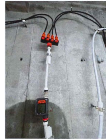
自動灑水系統定時器 Water Mist System Timer
